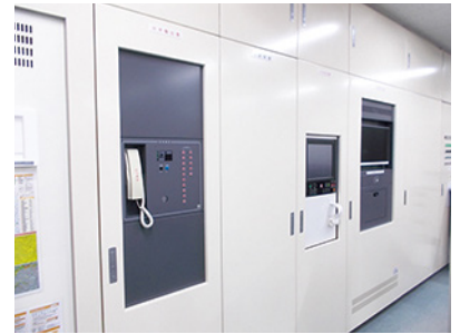
池下地下駐車場火災報知設備取替工事
