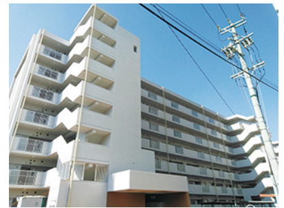
水室第4次公営住宅電気工事
