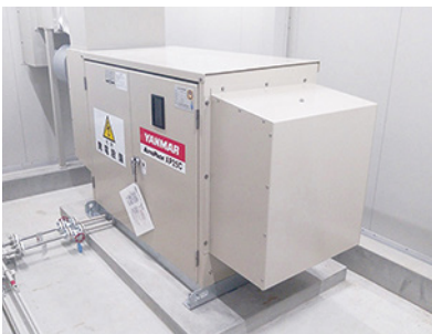
豊田市緊急防災対策河川工事
