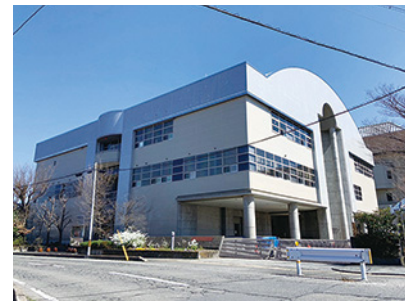
埋蔵文化財調査センター改修電気工事
