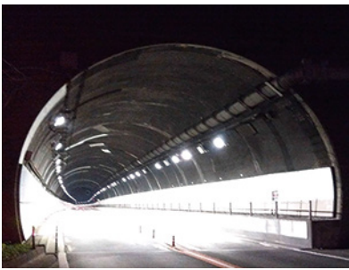
令和2年度静清維持原トンネル坑内
