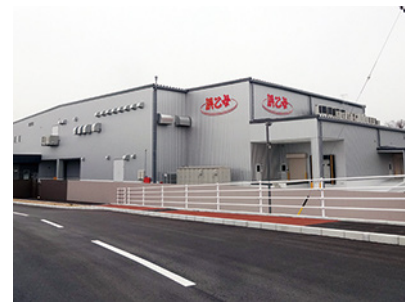
浜乙女三重工場電気設備改修工事
