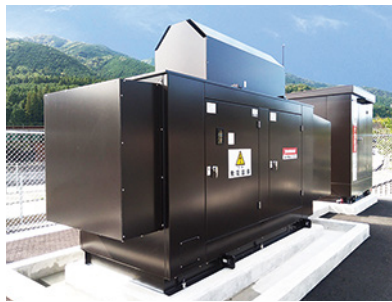
中呂道路排水施設受変電設備工事
