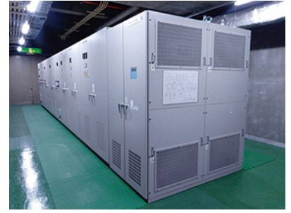
枇杷島スポーツセンター受変電設備取替
