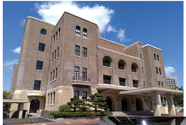
公会堂受変電設備改修工事
