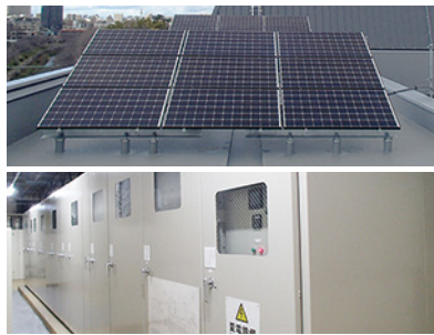
瑞穂公園体育館新築受変電設備工事
